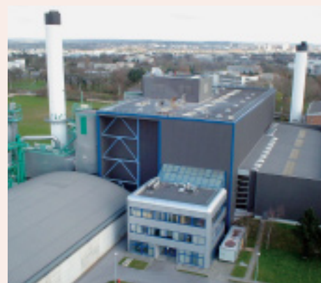
L'usine d'incinération des ordures ménagères de Rennes Métropole.
