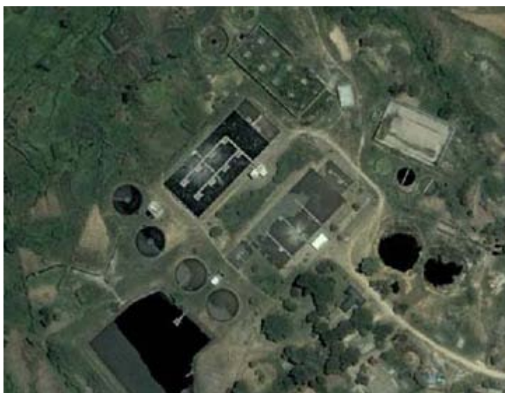
Station d'épuration installée au Zimbabwe
