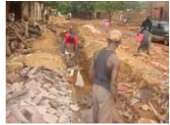
Photos de l'évolution des travaux.
