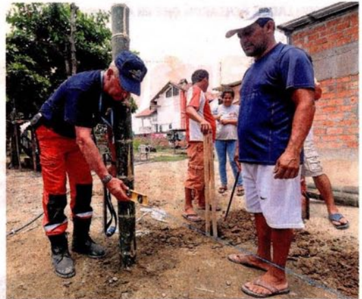
Militares franceses instalan plantas de potabilización de agua en Portoviejo.
